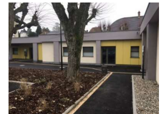
Altkirch (68) transformation d'un bâtiment vacant en pôle de services (BBC)
