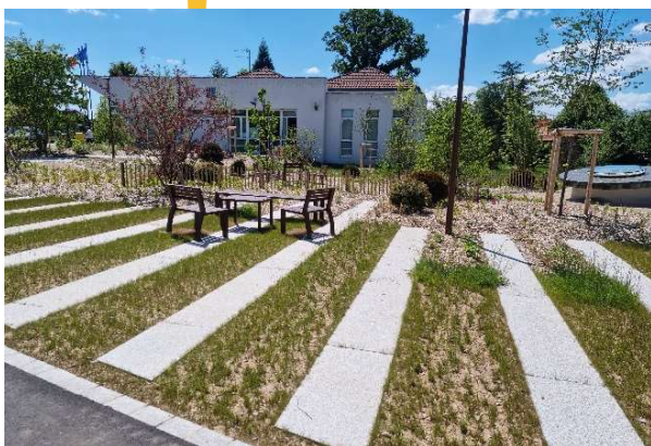
Photo après travaux
