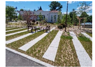
Gironcourt-sur-Vraine (54), Aménagement perméable de la place de la mairie
