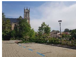
Maxéville (54), parking perméable et aménagement paysager
