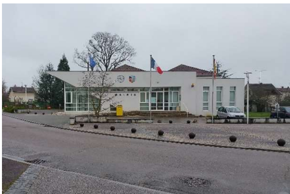
Photo avant travaux
