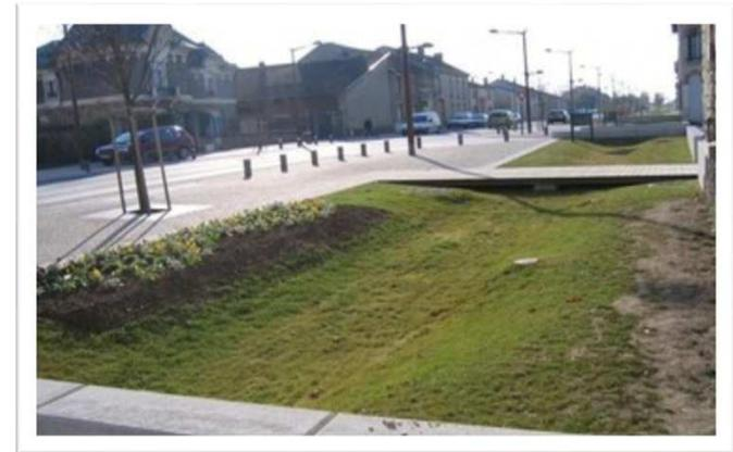
*Noue végétalisée permettant de stocker et d'infiltrer l'eau de pluie, Witry-les-Reims.
